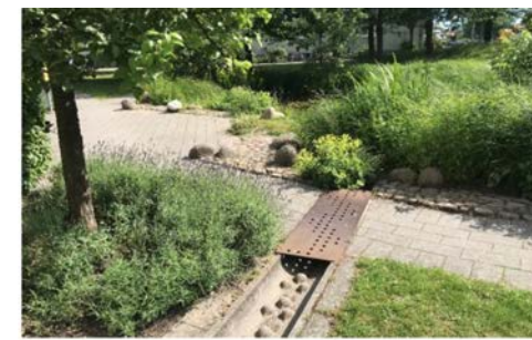
Ytlig vattenavledning, Augustenborg, Malmö
