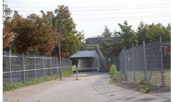
Cykelväg Norbergsgångens tunnel under kontinentalbanan
