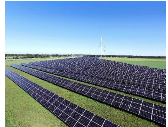
Solparken "Solsidan", Varberg
